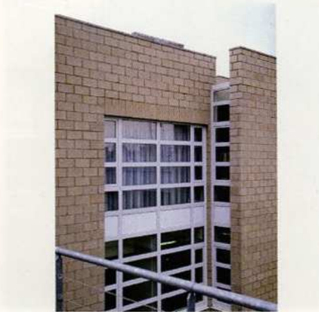
Lisse 19 - Hopital Avicenne Bobigny 92 - Architecte: Brusnel
