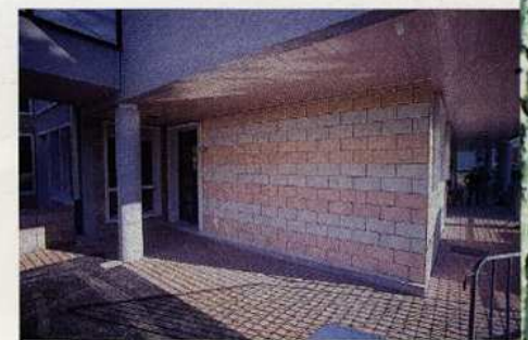
Lisse 19 - Ecole du Boccard Sallanches 74 - Architecte: Terrier
