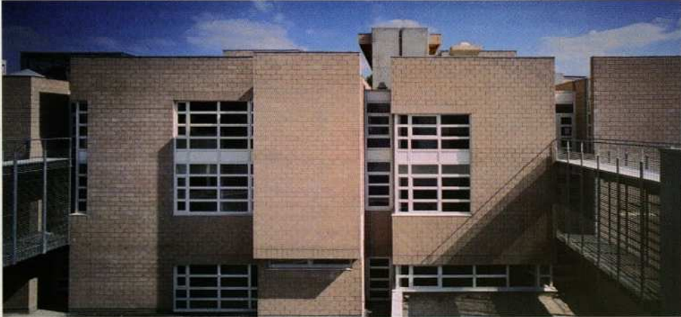
Lisse 19 - Hopital Avicenne Bobigny 92 - Architecte: Brusnel
