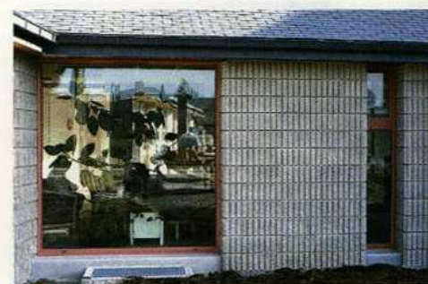
Split-Flute 19 - Maison des associations St Georges des Groseilliers (61) - Architecte: Meurice
