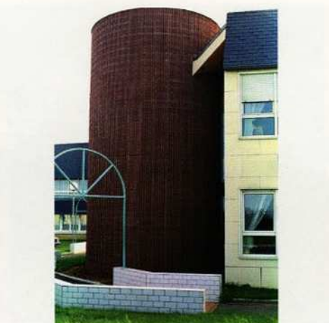
Split-Flute 19 - Maison de retraite Evron 53 - Architecte: Belliard
