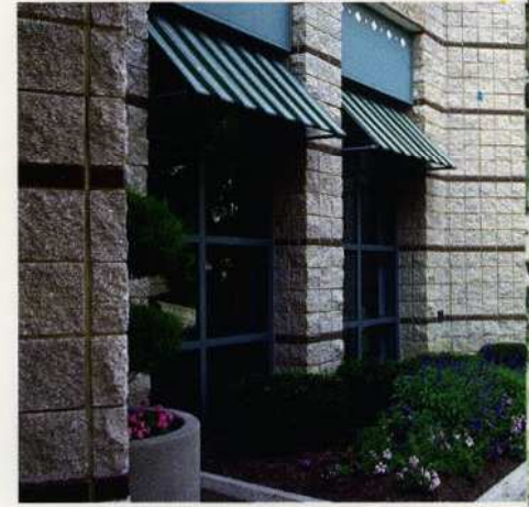
Splité 19 Demi & Planelle - Immeuble
