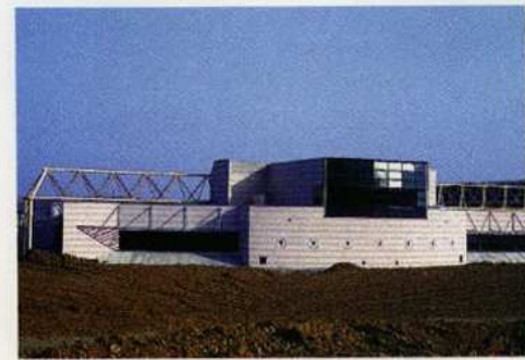
Lisse 19 - Centre Routier Communay 69 - Architecte: Moro
