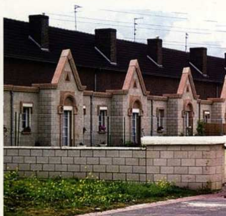
Lisse 19 - Rénovation cité Minière Avion 62 - Architecte: Binkowski
