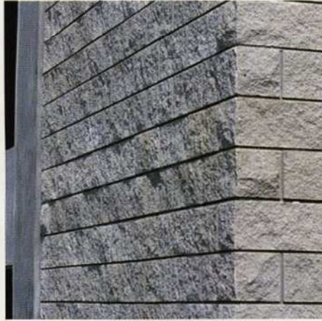
Splité 19 - Détail angle Villa Nîmes 30 - Architecte: Le Stum
