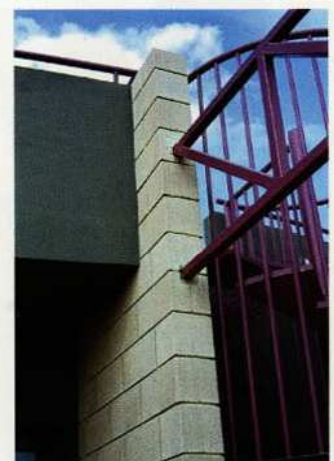
Lisse et strié 19 - Centre des métiers de l'environnement et de l'agriculture - Narbonne 11 - Architecte: Vitrou
