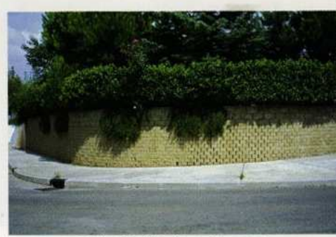
Splitte 19 - Mur de soutènement Beucaire 30
