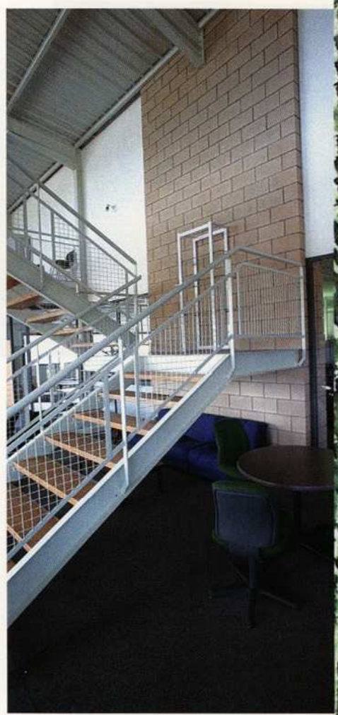
Lisse 19 - Bâtiment tertiaire St-Marcel les Valence 26 - Architecte: Chaussignan
