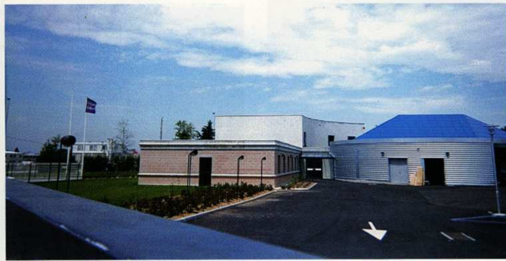
Lisse 19 - Bâtiment EDF Decines 69 - CabinetT BBC
