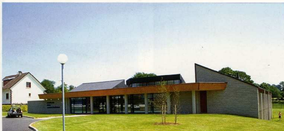
Split-Flute 19 - Maison des associations St Georges des Groseilliers (61) - Architecte: Meurice
