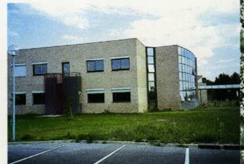
Lisse et strié 19 - Centre des métiers de l'environnement et de l'agriculture - Narbonne 11 - Architecte: Vitrou
