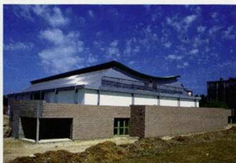
Split Flute et Strié 19 - Salle de sport Argentan 61 - Architecte: Juillard
