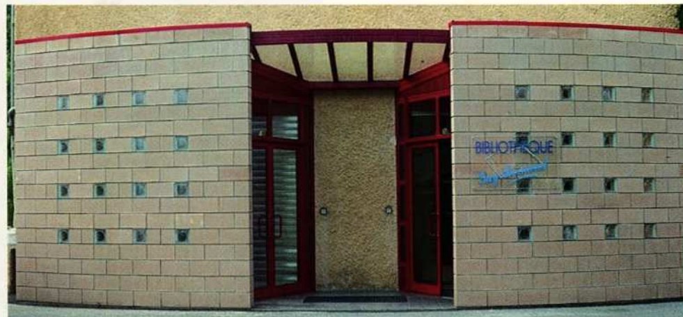
Lisse 19 -Groupe scolaire Gargas 84 - Architecte:Nicolas - APT
