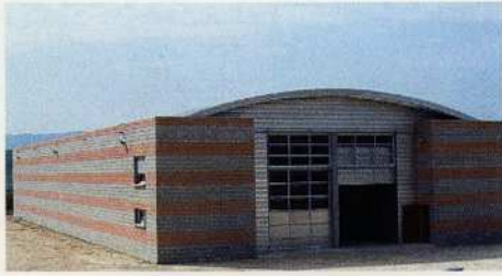
Lisse 19 -Coopérative fruitière Villars 84 - Architecte:: Jouve
