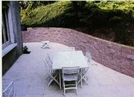
Splité 19 - Mur de soutènement Villa - Lorient 26
