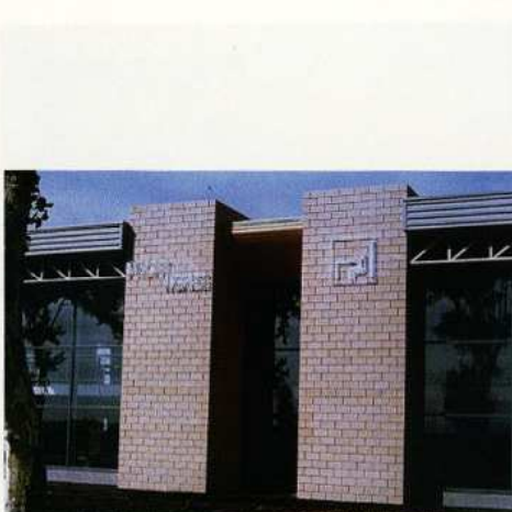
Lisse 19 - Bâtiment tertiaire St-Marcel les Valence 26 - Architecte: Chaussignan
