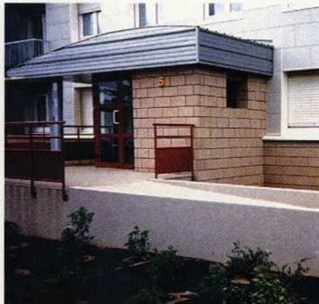
Srié 19 - Rénovation HLM Redon 35 - Architecte : Hay
