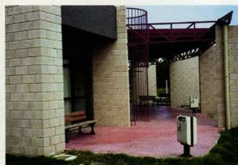
Lisse et strié 19 - Centre des métiers de l'environnement et de l'agriculture - Narbonne 11 - Architecte: Vitrou
