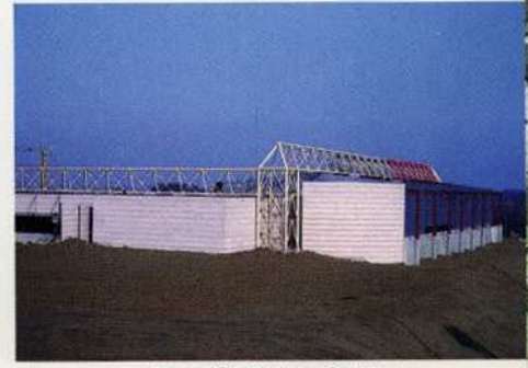
Lisse 19 - Centre Routier Communay 69 - Architecte: Moro
