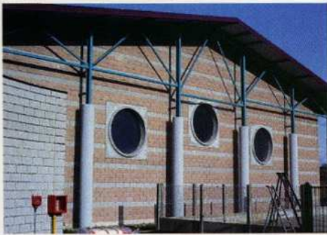
Strié 19 - Gymnase Chassieu 69 - Architecte: Theriaux
