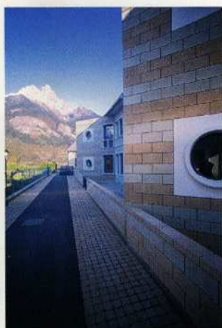
Lisse 19 - Ecole du Boccard Sallanches 74 - Architecte: Terrier
