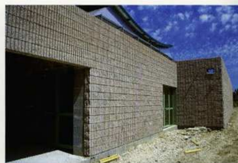
Split Flute et Strié 19 - Salle de sport Argentan 61 - Architecte: Juillard
