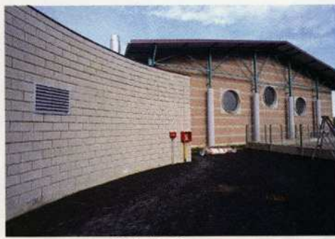
Strié 19 - Gymnase Chassieu 69 - Architecte: Theriaux
