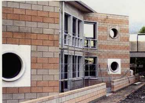
Lisse 19 - Ecole du Bocard Sallanches 74 - Architecte: Terrier
