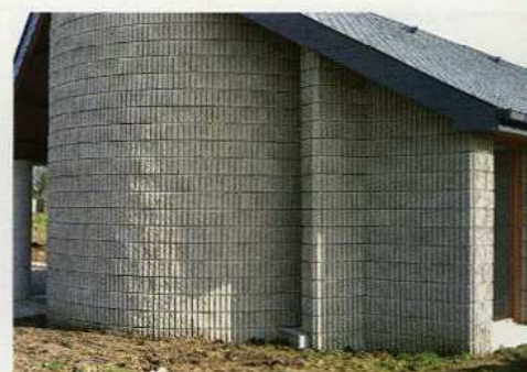
Split-Flute 19 - Maison des associations St Georges des Groseilliers (61) - Architecte: Meurice
