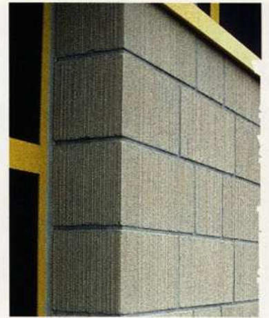
Détail Strié 19 - Ecole de Musique Outreau 62 - Architecte: Fievet
