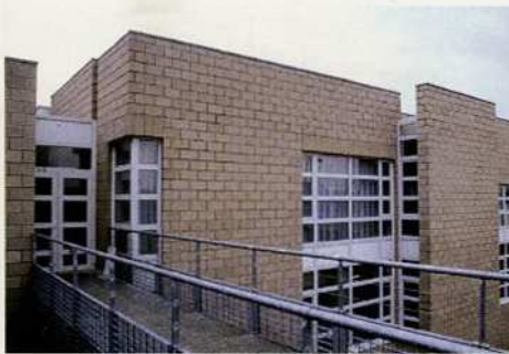
Lisse 19 - Hopital Avicenne Bobigny 92 - Architecte: Brusnel
