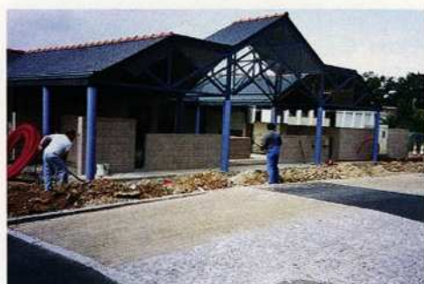
Lisse 19 - Ecole maternelle Chavagne 35 - Atelier du Canal.
