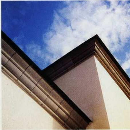
Détail :Corniches Betobat - Immeuble Laval 35
