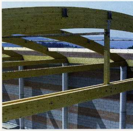
Lisse 19 -Coopérative fruitière Villars 84 - Architecte:: Jouve
