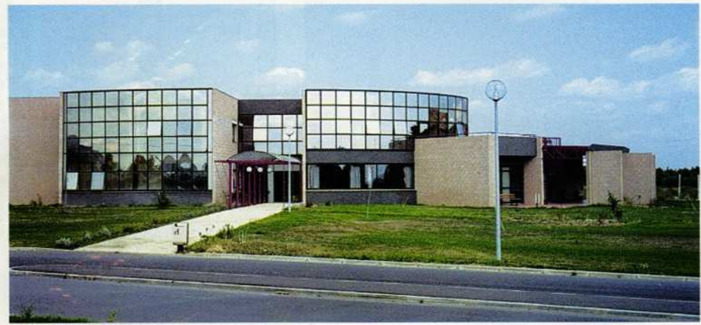
Lisse et strié 19 - Centre des métiers de l'environnement et de l'agriculture - Narbonne 11 - Architecte: Vitrou
