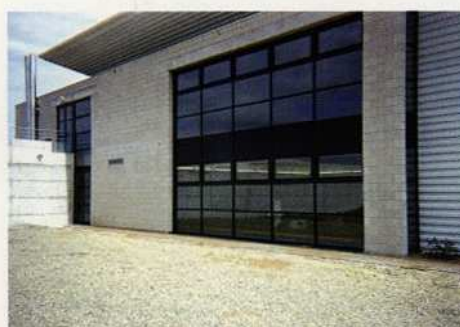
Lisse 19 - Salle de Sport St Mars du Désert 44 - Architecte: Ménard
