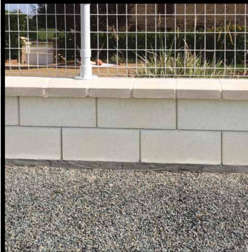
Le muret GARDEN® est composé de blocs GARDEN® éléments polyvalents, conçus avec des précoupes qui, après une préparation simple, permettent de réaliser des blocs standards, des angles et des demi-blocs. Notre gamme GARDEN® inclut les Couronnements, blocs Piliers et les Couvertines, disponibles en deux dimensions et deux coloris, afin de s'adapter à l'esthétique de vos espaces extérieurs.
