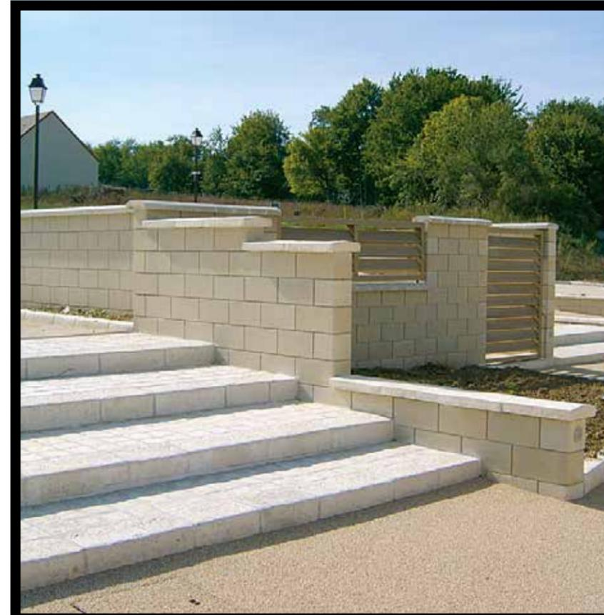
Les blocs apparents TETRIX® sont empilés à sec, grâce à leur système d'emboîtement exclusif. Ils sont solidarisés par un remplissage de béton. (110 litres /m<sup>2</sup>)
