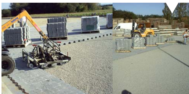
Une personne est sur la machine de pose, l'autre met les pavés manquant du milieu et aligne les pavés, et le troisième compacte la zone avant sablage.
