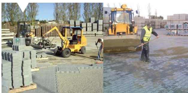
Si vous êtes intéressés, n'hésitez pas à visiter un de ces 2 chantiers : - Denis Matériaux - ZA Chateauguillard 35470 Bain de Bretagne - TPM - ZA du Guily 56 920 Noyal Pontivy
