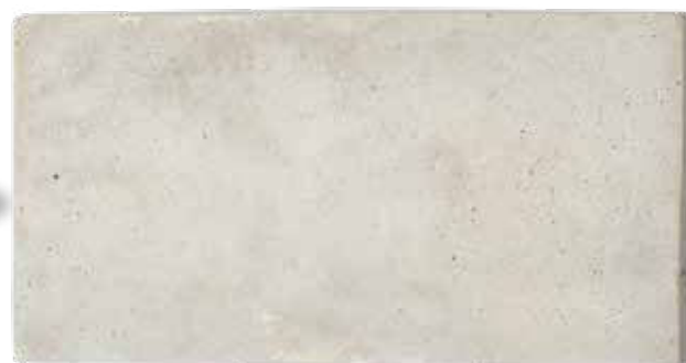
Dalle de soubassement
