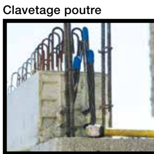
Clavetage poutre
