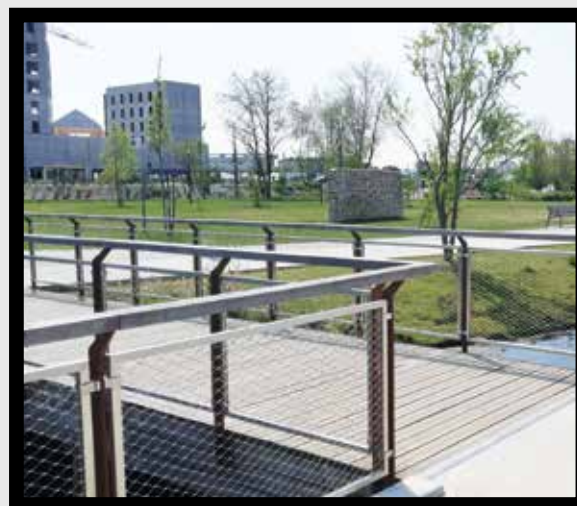
Passerelle parc Baud Chardonnet Rennes 35
