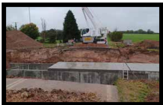
Pose plafond Boviduc
