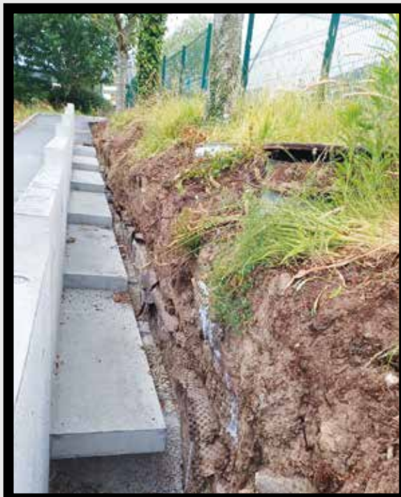
Arrière mur de soutènement Pluguffan 29
