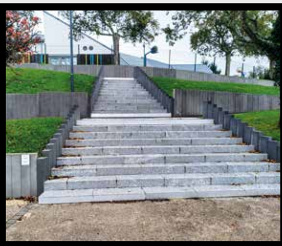
Mur de soutènement Pluguffan 29
