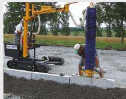
Pose de bordures TP mécanisée
