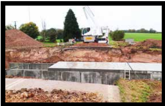
Pose plafond Boviduc
