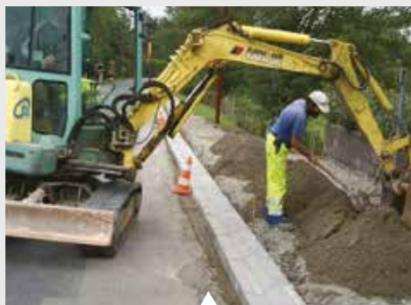
Pose de bordures TP
